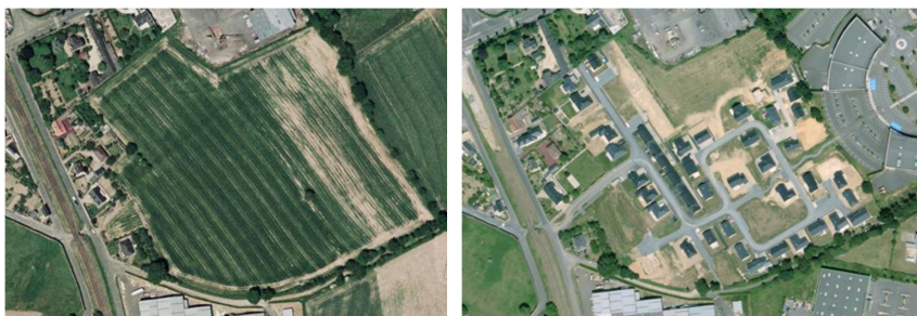
Avant / Après - Consommation des terres agricoles pour permettre la construction d'un lotissement – Château-Gontier (sources : IGN)
