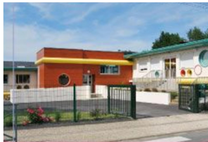
La Maison de la Petite Enfance à Château-Gontier
