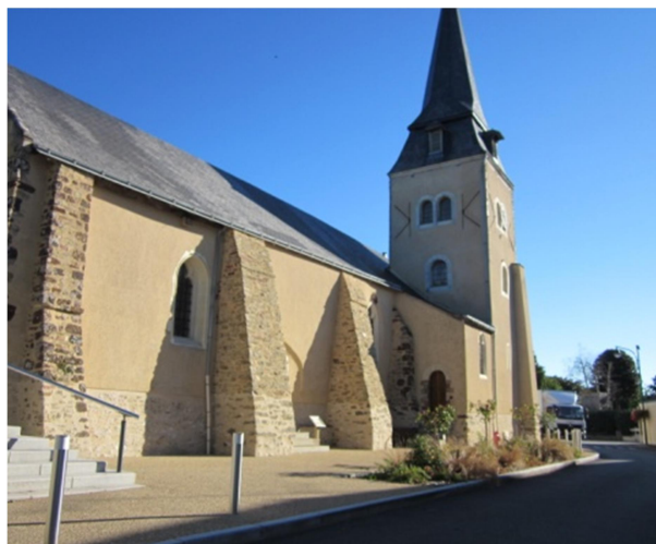
Eglise de St Fort
